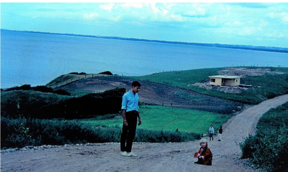
Grusvej ved slutningen af det nuværende Skelbakken.
